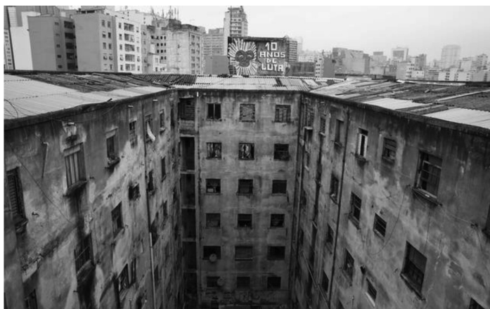
CONJUNTO RESIDENCIAL ABANDONADO NO CENTRO DE SÃO PAULO OCUPADO PELO MOVIMENTO DOS TRABALHADORES SEM-TETO
